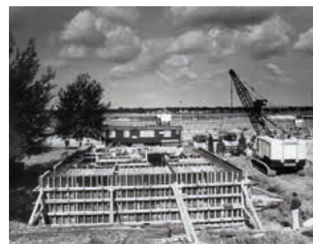
De atoomschuilkelder, hier in aanbouw in 1980, is op 22 juni te bezichtigen.
