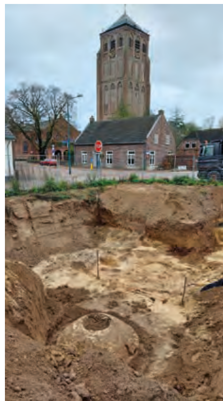
Bakstenen put in de diepte
