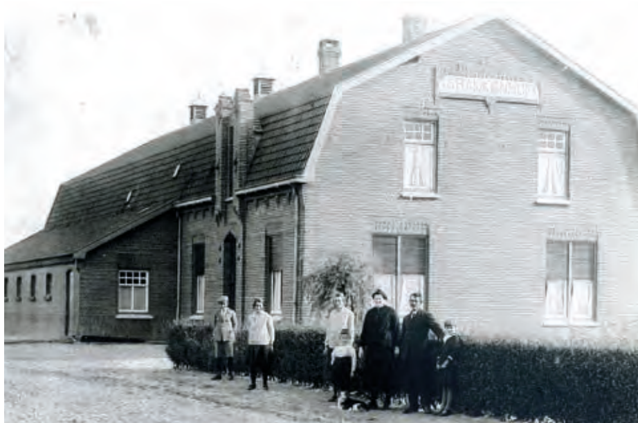
Midden in het gebied de Brakken bouwde Jan Melsen in 1923 zijn boerderij de Brakkenhof, naar een ontwerp van architect Adriaan de Leeuw-Perre.
